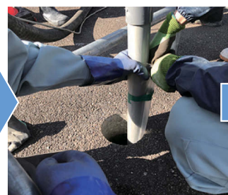
③充填材（流動化処理土）を注入
