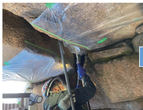
①ジュウテンバッグに発泡ウレタン注入
