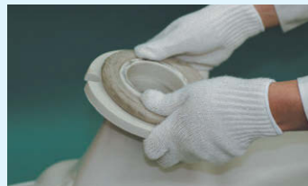
便器にガスケット取付
