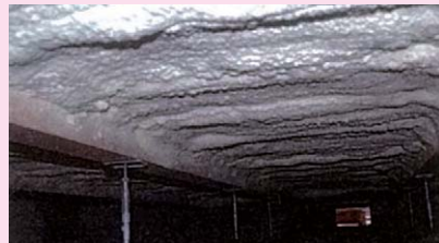
既存床下からの吹付け硬質ウレタンフォーム施工例
