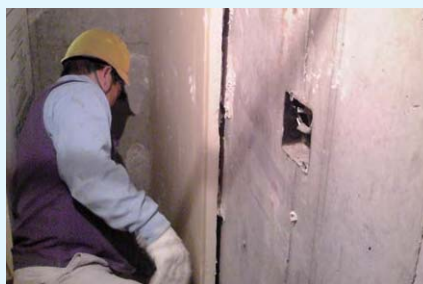
コンクリート壁への断熱材複合パネル施工例
