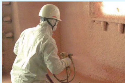
コンクリート壁への吹付け硬質ウレタンフォーム施工例
