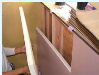
下地材への断熱材複合パネル施工例
