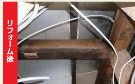
屋根裏面への断熱ボード施工前後例
