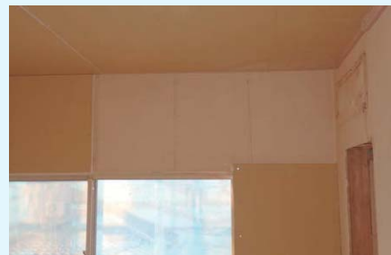
既存壁への断熱材複合パネル上張り施工例
