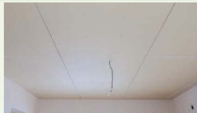
既存天井への断熱材複合パネル上張り施工例
