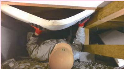
既存床下からの根太間への断熱ボード施工例
