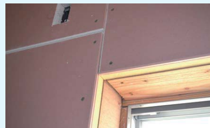
下地材への断熱材複合パネル施工例
