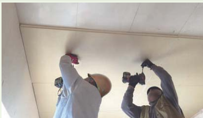
既存天井への断熱材複合パネル上張り施工例
