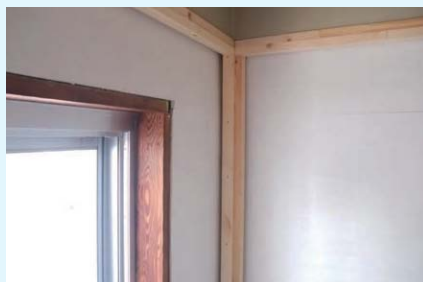
コンクリート壁への断熱ボード施工例
