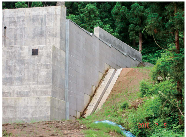
施工場所：新潟県
