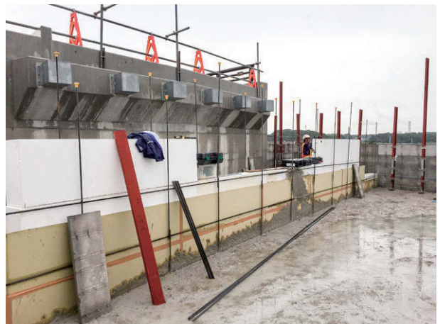
施工場所：福島県
