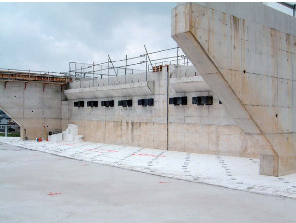
施工場所：高知県
