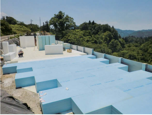
施工場所：新潟県
