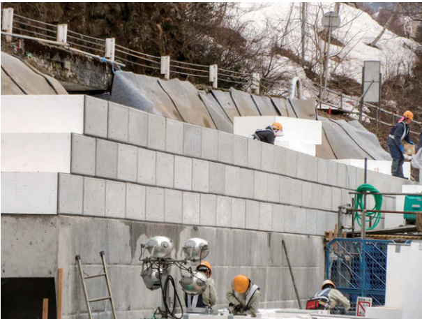
施工場所：新潟県
