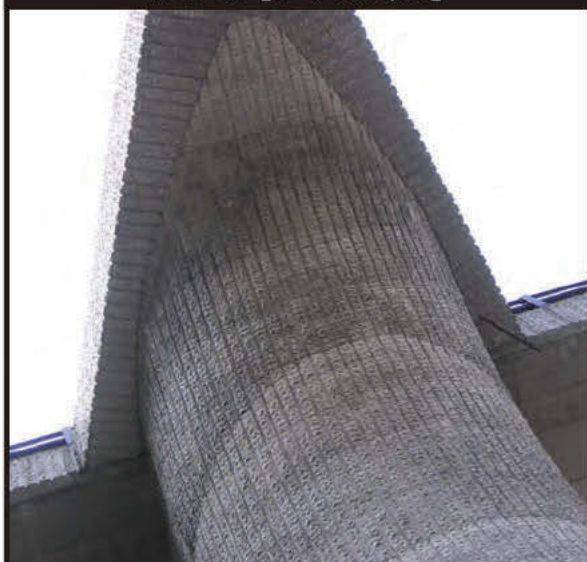
橋脚（ピア）施工例を下から望む
