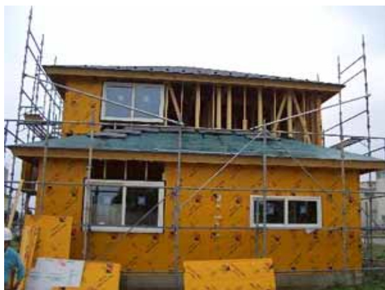
ハイブリッド断熱ボード施工風景
