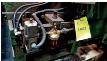
圧縮空気が漏れている箇所へのタグ付け
