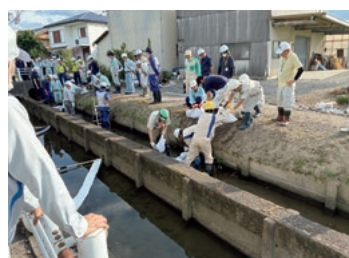
のうせ 土嚢堰き止め訓練 (滋賀県)
