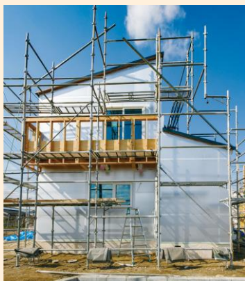
高性能硬質ウレタンフォーム断熱材「キューワンボード」。面材には遮熱性能に優れた赤外線高反射アルミ箔を採用し省エネ効果を狙う
