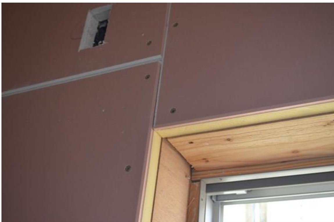
施工後の様子
