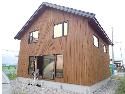
写真:「北総研防火木外壁」の施工例
