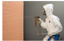
現場発泡吹付け断熱材
