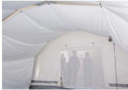
天井部から側面まで内張り布を取り付けます。結露落下の防止に効果があります。
