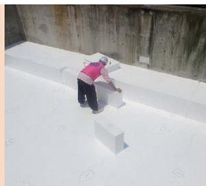
ピット内部に隙間が生じない様コープランRTを積み上げて埋戻していきます。
