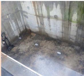
水抜き穴の削孔を行います。ピット外部からの浸水や万が一の事態に備え、水抜き穴を開けます。削孔した穴には、ステンレス製の蓋をかぶせます。
