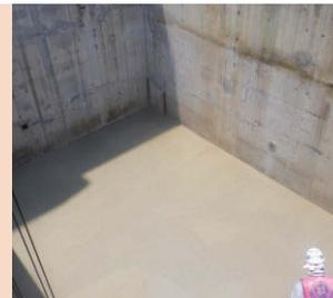
ピット底の不陸をレベリング材で調整します。
