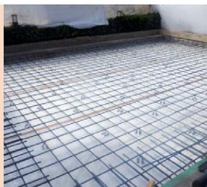
差し筋アンカーの打込み・鉄筋の配筋作業を行います。
