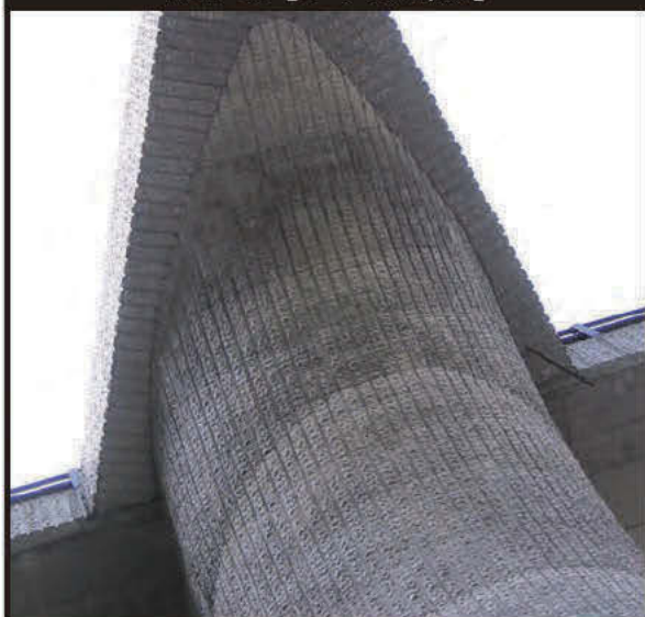
橋脚（ピア）施工例を下から望む
