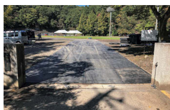
建設現場入口
